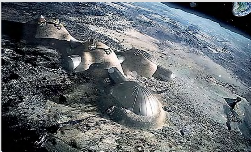
Eine Projektgruppe der ESA testet, ob man Mond-Habitate aus Regolith im 3D-Druck vor Ort erstellen kann. Die aufgeblasene Kuppel dient als innere Hülle und Stützkonstruktion, ein Roboterfahrzeug appliziert schichtweise Regolith und fixiert diesen mit Bindemitteln. Foto: ESA/Forster+Partners
