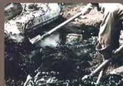
SUCHE IN DEN TRÜMMERN
