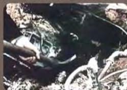
SUCHE IN DEN TRÜMMERN
